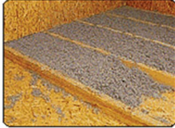
Расход Эковаты при укладке на горизонтальные поверхности ручным способом составляет 45 кг/м3.
