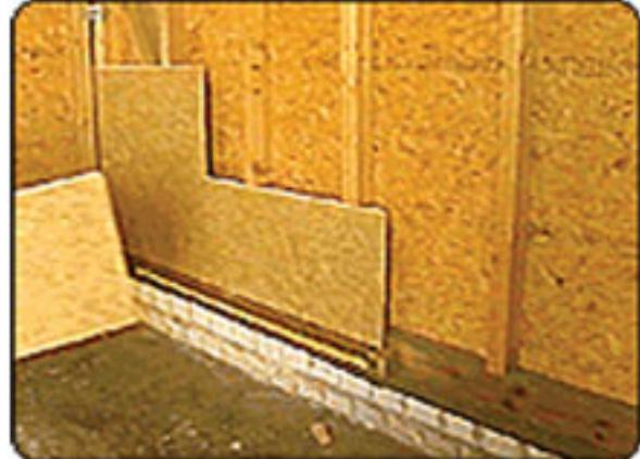
В образовавшуюся полость высыпаем предварительно распущенную Эковату и равномерно распределяем.
