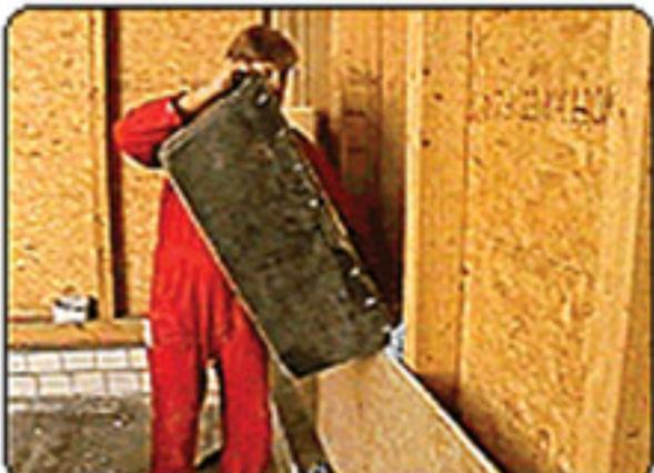
Утрамбовываем рукой до пружинящего состояния. Плотность эковаты в стене должна быть 65 кг/ м3. Затем наращиваем следующие полметра обшивки и т. д.
