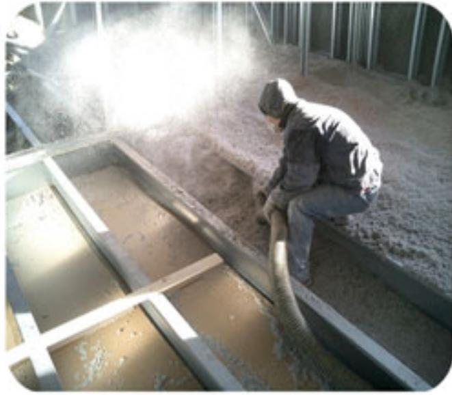
Наиболее распространенный и удобный способ утепления Эковатой, где утеплитель подается с помощью выдувной установки по шлангу к месту утепления. Незаменим в каркасном домостроении.
