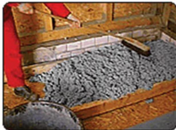
Раскладываем Эковату на утепляемую поверхность ровным слоем.
